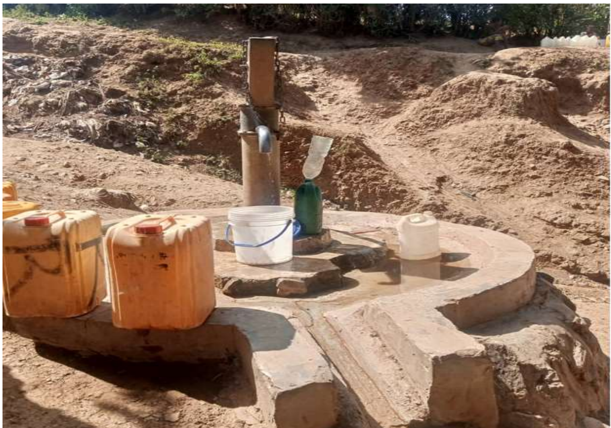
Figure 5 : Puits d'eau bien protégé
