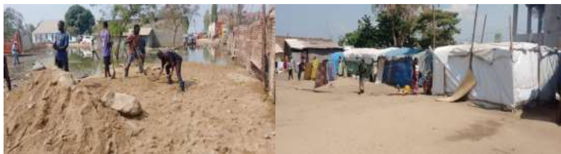
Figure 2. Travaux de remblai destinés à rehausser le terrain (à gauche), et installation de tentes pour héberger les ménages déplacés à Kavimvira (à droite).
